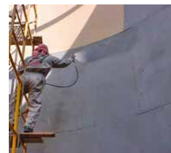
Футеровка резервуаров
