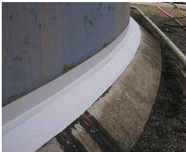
Герметизация основания резервуара
