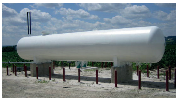
Для дополнительной защиты нанесен верхний слой Belzona 5111
