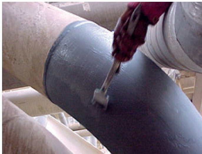
Применение Belzona 5851 для защиты трубы от коррозии
