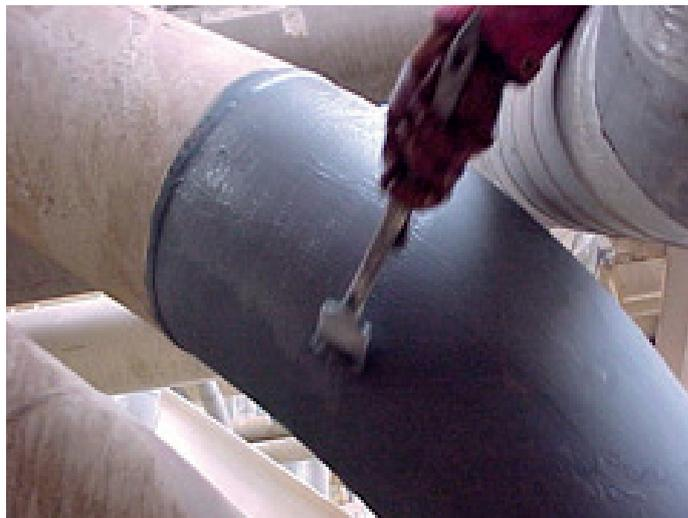
Применение Belzona 5841 для защиты трубы от коррозии
