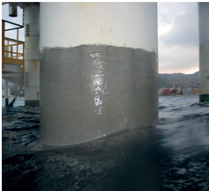
Belzona 5831 (ST-Barrier) — толерантное к влаге барьерное покрытие для защиты металлических и неметаллических поверхностей вне помещений.
