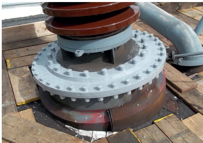
Применение Belzona 5831 для устранения утечки трансформаторного масла
