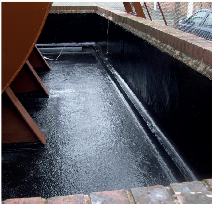
Belzona 4351 — двухкомпонентное токорассеивающее покрытие, предназначенное для отведения скопившегося электростатического заряда из опасных зон. Превосходные токорассеивающие свойства Belzona 4351 позволяют снизить вероятность электростатического разряда, который может стать источником возгорания в зонах хранения воспламеняющихся материалов.
