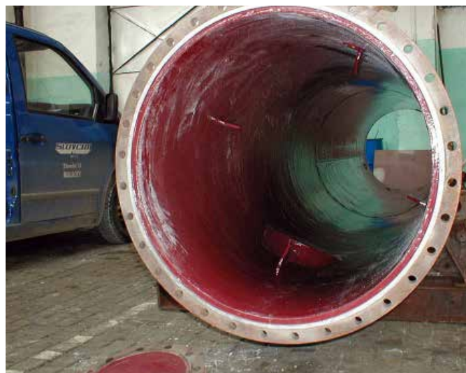
Дополнительная защита нанесена на внутреннюю поверхность химического реактора
