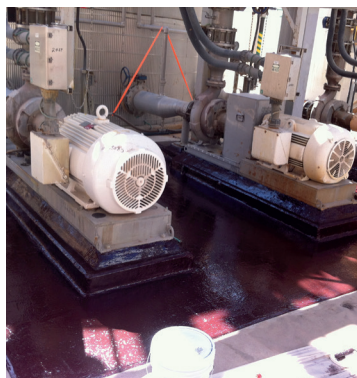
Простое нанесение кистью для защиты поверхностей любой формы от химических воздействий
