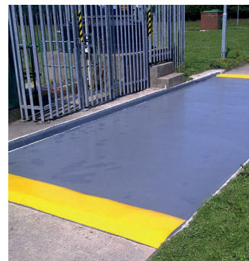
Благодаря высокой прочности на сжатие этот материал идеально подходит для участков загрузки и выгрузки химических реагентов.
