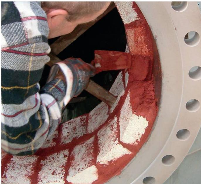
Belzona 4181 (AHR Magma-Quartz) — кислотостойкая и термостойкая система для ремонта и защиты бетона, камня и других жестких подложек в условиях ударных, абразивных и химических воздействий.
