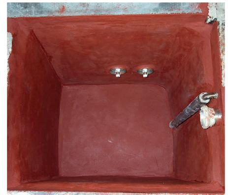
Отстойник с нанесенным покрытием
