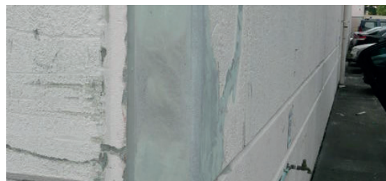
После инъецирования Belzona 4151 использовали Belzona 4111 для заполнения трещин
