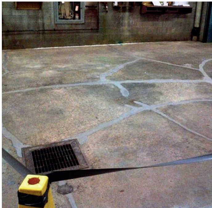
Ремонт трещин с применением Belzona 4151 и 4111.
