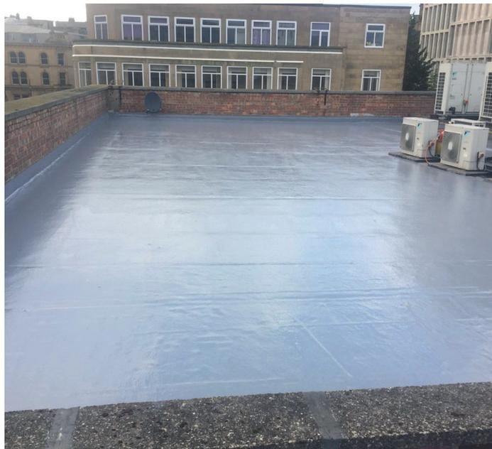
Belzona 3131 (WG Membrane) — однокомпонентная система холодного нанесения для долговечного ремонта и длительной защиты кровли, пригодная для применения в любых погодных условиях.
