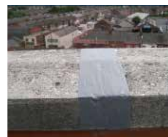
Швы в парапетных стенах и каменных карнизах
