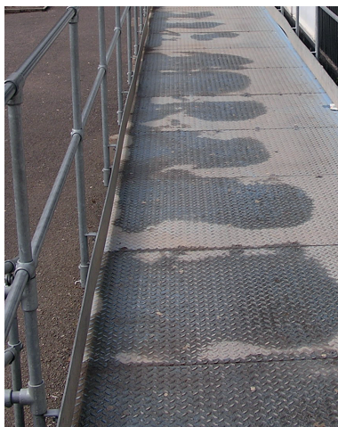
Стальной пандус до нанесения покрытия
