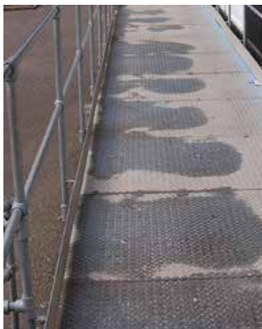
Стальной пандус до нанесения покрытия
