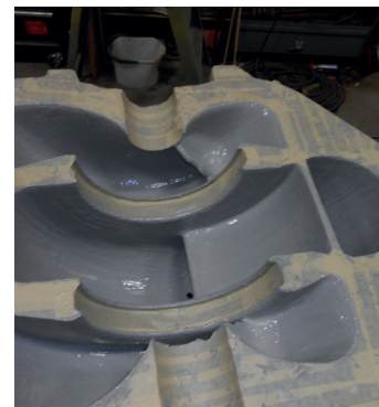
Внутреннее покрытие насосов
