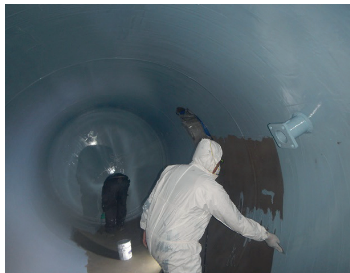
Нанесение Belzona 1391T вручную
