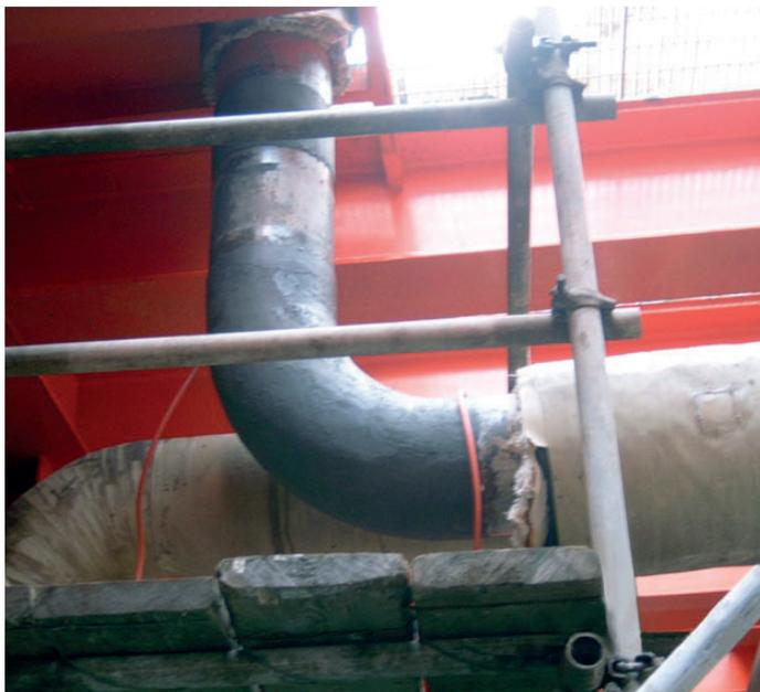
Belzona 1251 (HA-Metal) — однокомпонентная система для ремонта и защиты металлических поверхностей на работающем оборудовании.
