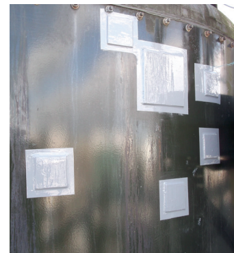
Крепление пластин методом полимерной сварки
