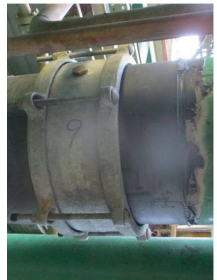
Муфта после ремонта
