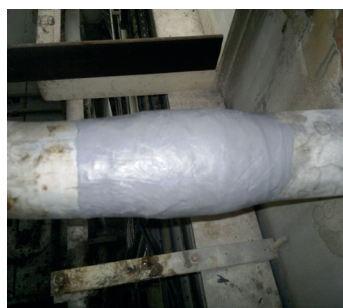
Композитный ремонт труб и устранение локальных дефектов
