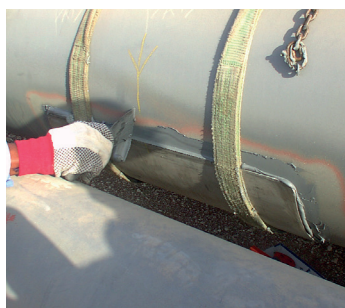
Полимерная сварка и выравнивание оснований
