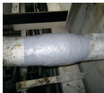
Композитный ремонт труб и устранение локальных дефектов
