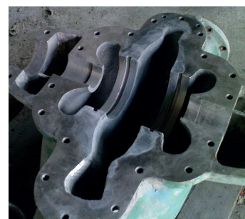
Герметизация и уплотнение, заполнение пустот
