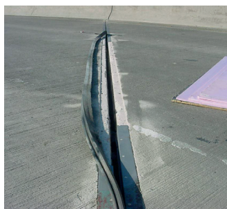
Разрушенный шов
