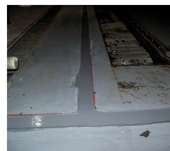
Шов отремонтирован с использованием Belzona 4521
