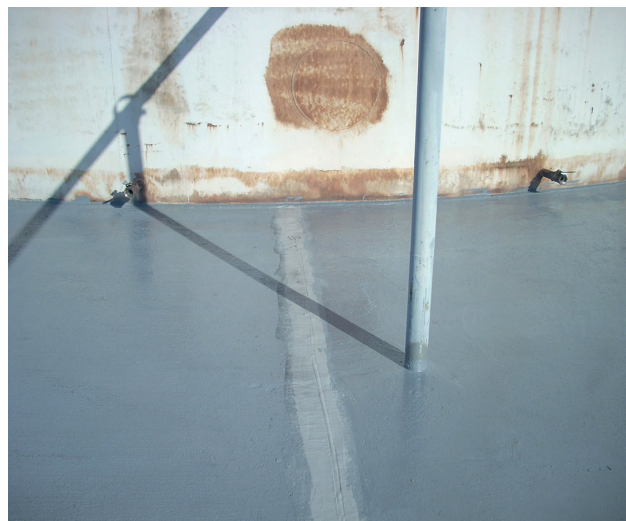
Применение для обновления пострадавших швов в зоне обвалования
